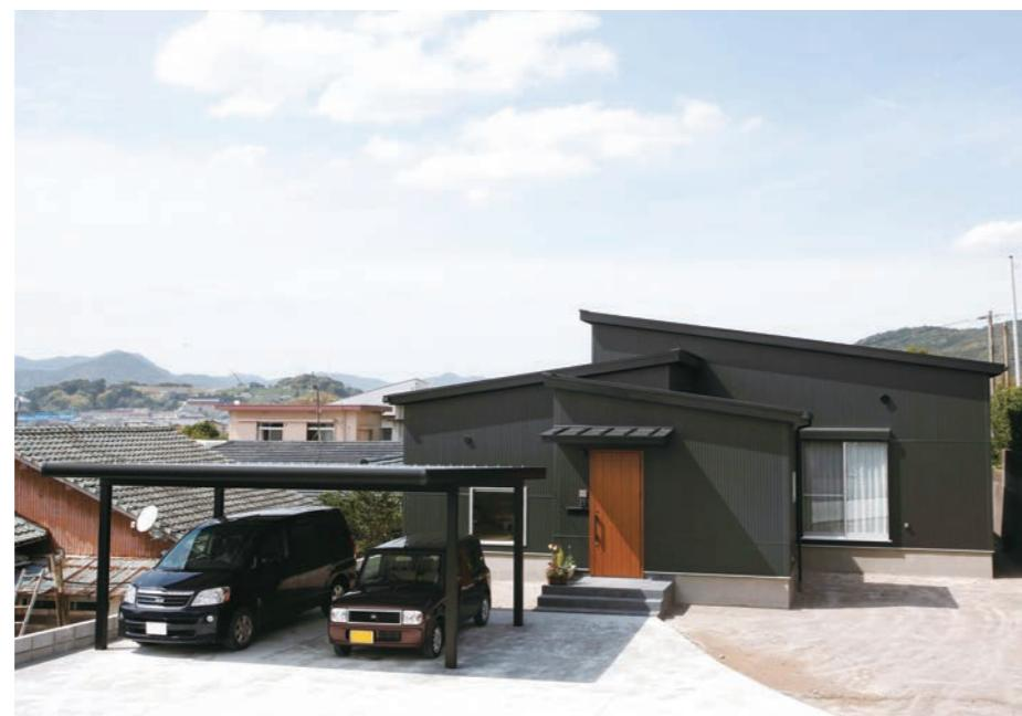
海が近く風の強い地域のため、構造用合板にサイディングを重ねて十分な強度を確保。周囲に背の高い建物がなく、南側の窓から外光が取りやすい。
